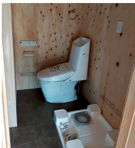
トイレ (ウォシュレットあり)・脱衣所
