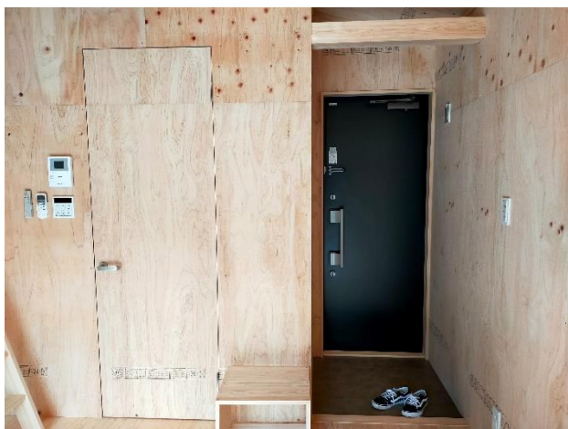
(左) トイレ・浴室入口/玄関 (右)
